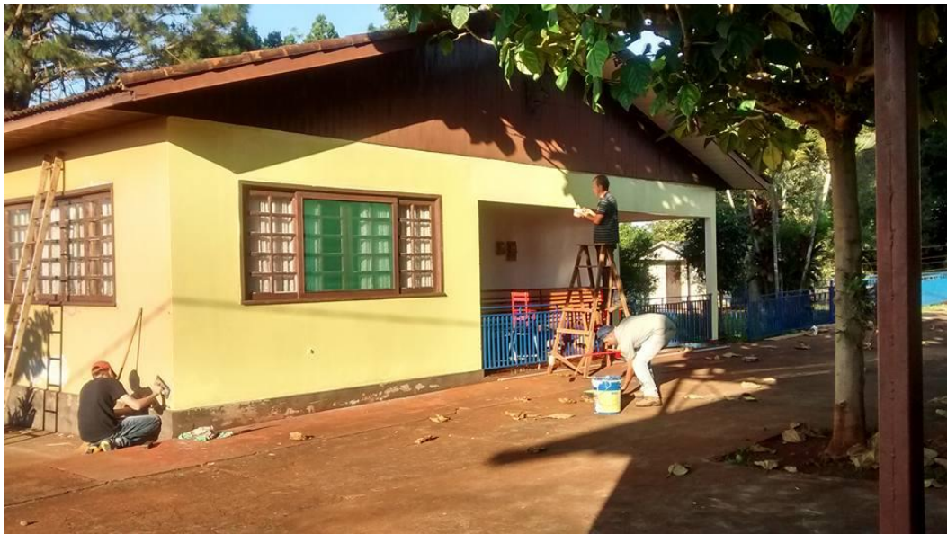
Fleißige Helfer beim Anstreichen der Häuser
