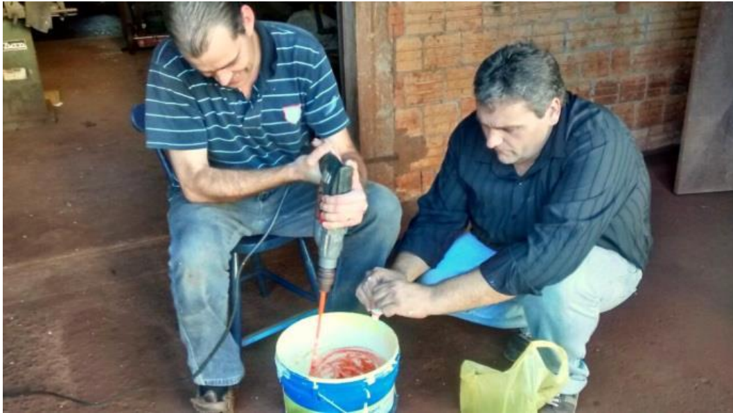
Christoph und Jaime beim Zubereiten der Farbe für die Renovierungsarbeiten
